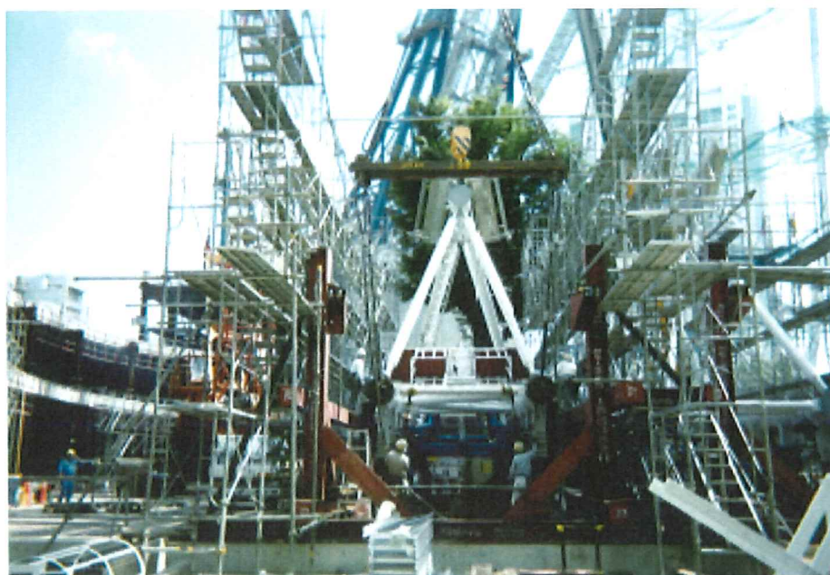
観覧車地組状況
